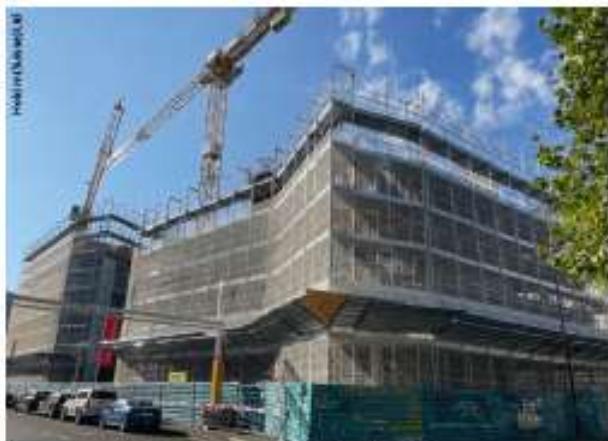
Vue récente du chantier en cours rue des Maraîchers.
