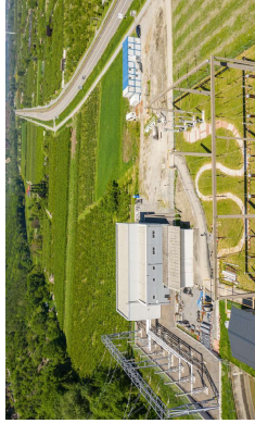
Poste de La Bâtiatz
